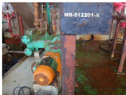
Bomba Água Quente - B-5122001-A
