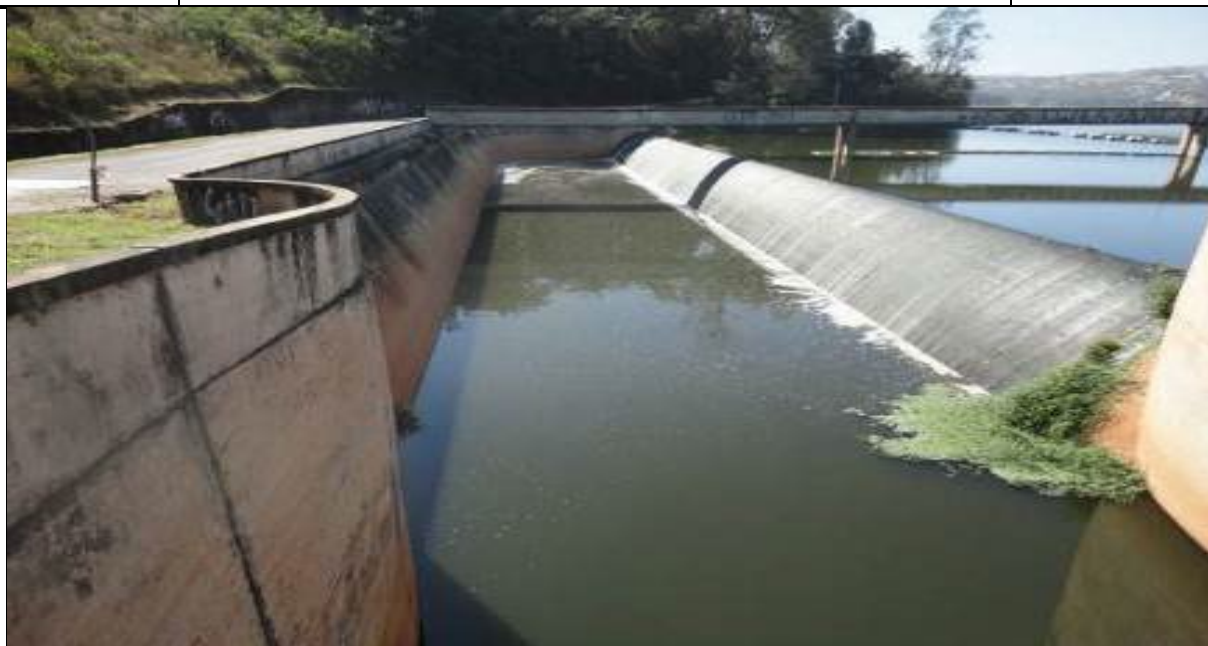
Figura 3 - Emboque do vertedouro de superfície (tipo slide-channel).
