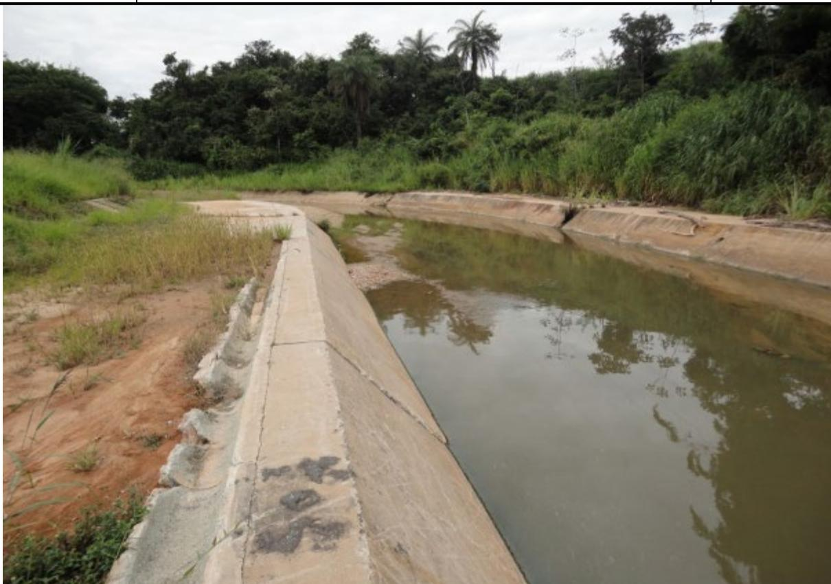
Figura 11 - Canal de jusante do Córrego de Pintado revestido em concreto após o sistema extravasor da LAP.
