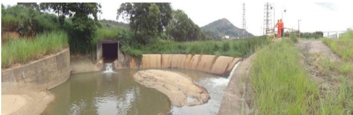
Figura 12 - Vista panorâmica do emboque do canal Córrego Pintado e do sistema extravasor deca milenar da LAP. A direita pode-se notar o talude de jusante da barragem da LAP.
