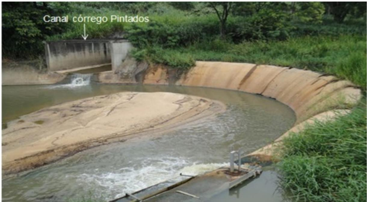
Figura 10 - Emboque do sistema extravasor tipo side-channel da LAP.
