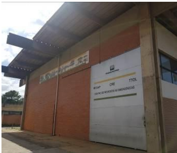
Figura 12 - Galpão do CRE.
