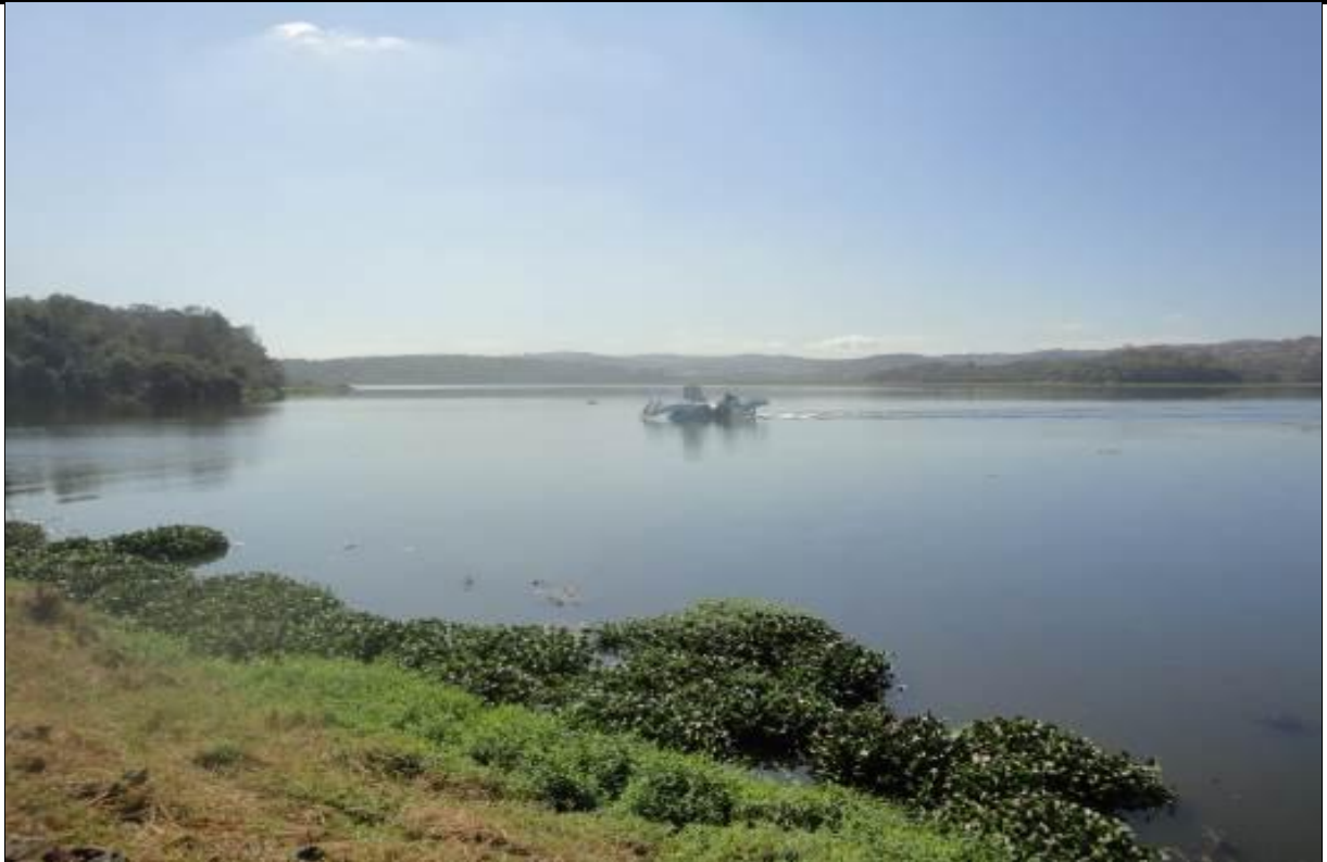
Figura 5 - Reservatório da barragem Ibirité.
