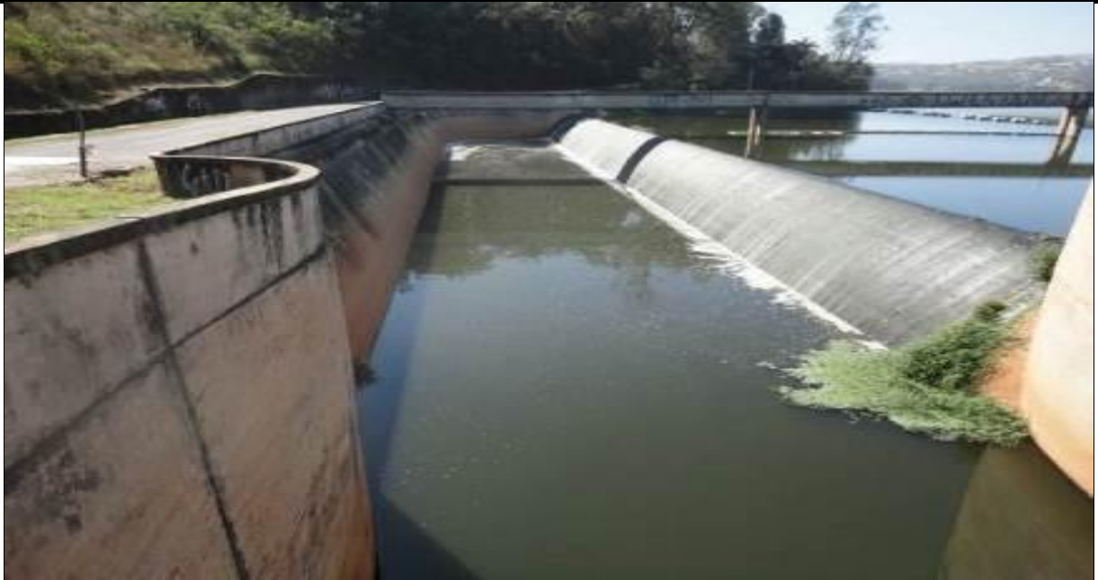
Figura 3 - Emboque do vertedouro de superfície (tipo slide-channel).
