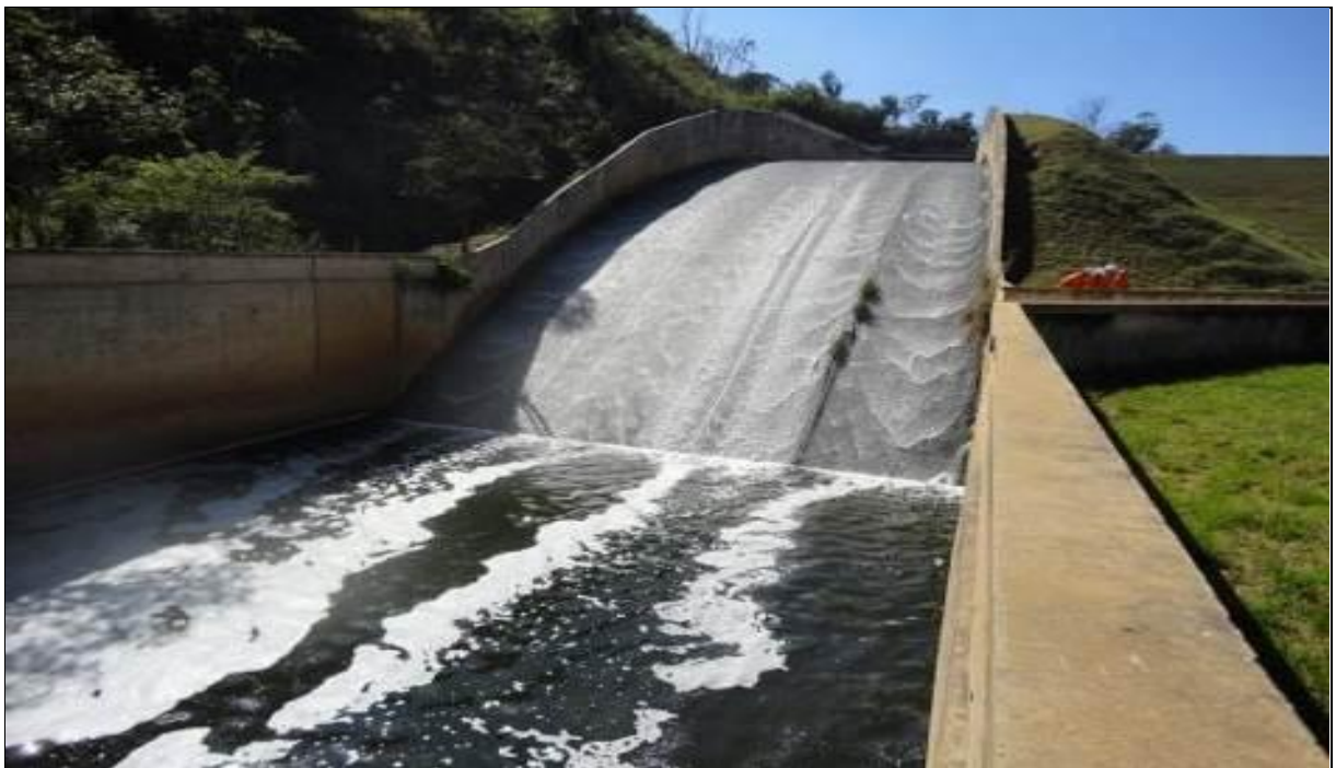
Figura 4 - Rápido do vertedouro de superfície.
