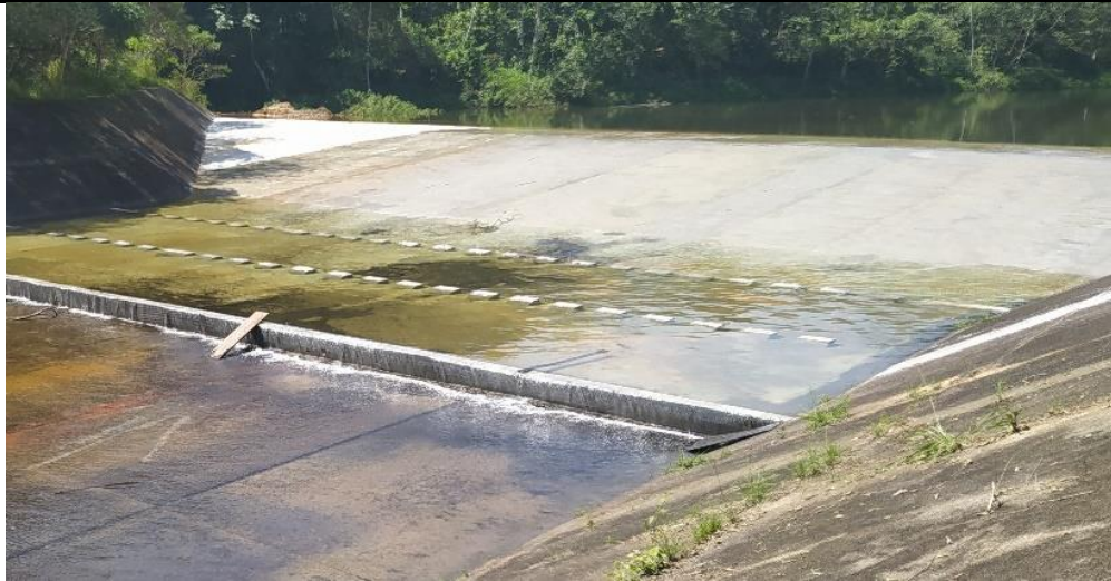
Figura 3.3-2 - Vertedor de da barragem de Saracuruna atualmente
