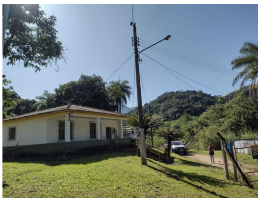
Figura 11-1 – Localização da sirene da barragem de Saracuruna – Rua Marcio S. Silva – Vila Santa Alice, Duque de Caxias - RJ -(Coordenada geográficas: 22°33'17.2''S; 43°16'30.6''W)
