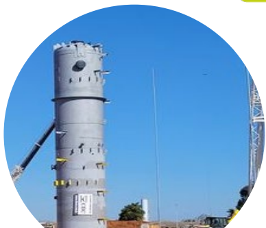
Instalação da torre secadora à vácuo na REPLAN
