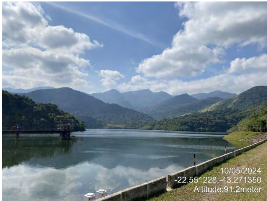
Figura 44: Vista geral do reservatório.
