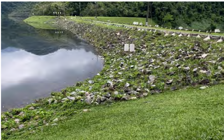
Figura 5: Vista geral do talude de montante.
