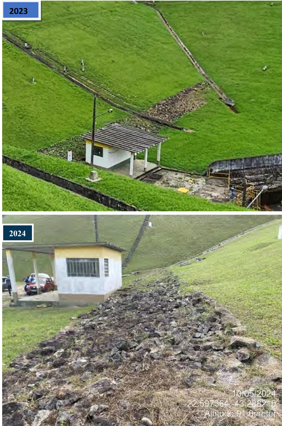
Figura 17: Comparativo entre a vegetação presente no enrocamento do dreno durante as inspeções de 2023 e 2024.
