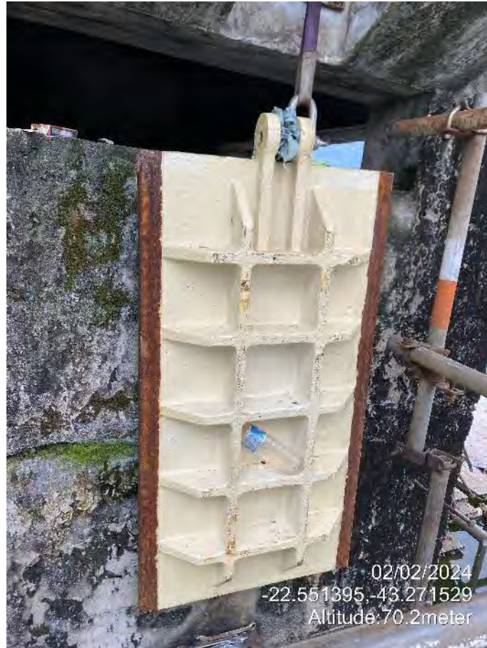
Figura 51: Comporta após manutenção antes de ser instalada (Registrado em Fevereiro de 2024)
