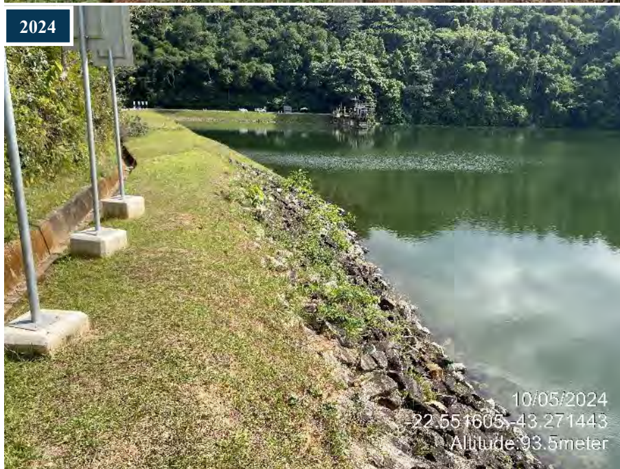
Figura 31: Comparativo da presença de vegetação na ombreira esquerda a montante nas inspeções de 2023 e 2024.
