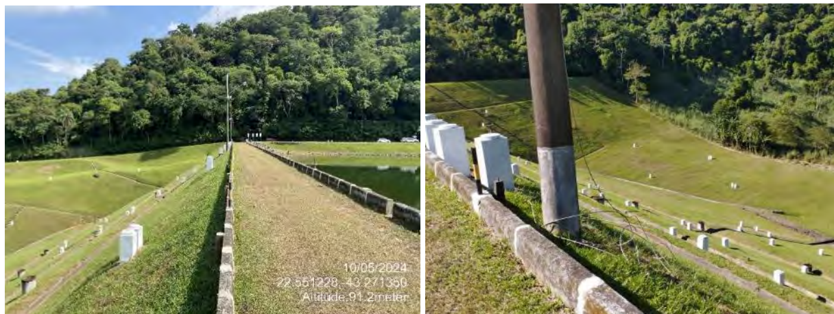
Figura 3: Crista possui postes com iluminação, no entanto, o sistema elétrico não está funcionando.
