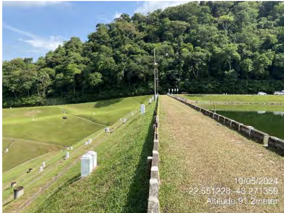
Figura 7: Vista geral da crista da Barragem Saracuruna
