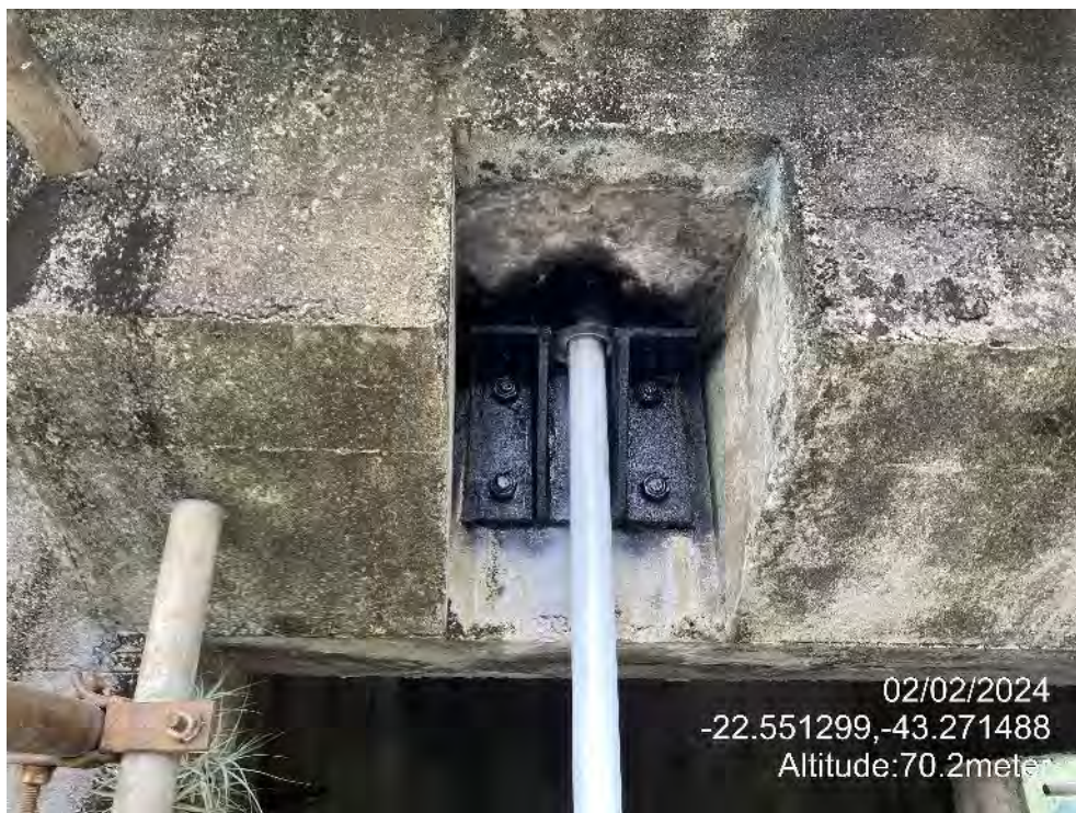
Figura 52: Mancal e haste substituídos após manutenção (Registrado em Fevereiro de 2024)
