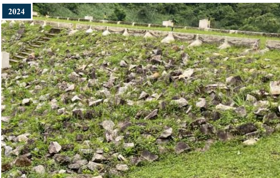
Figura 6: Comparativo entra o crescimento de vegetação entre o enrocamento durante as inspeções de 2023 e 2024.
