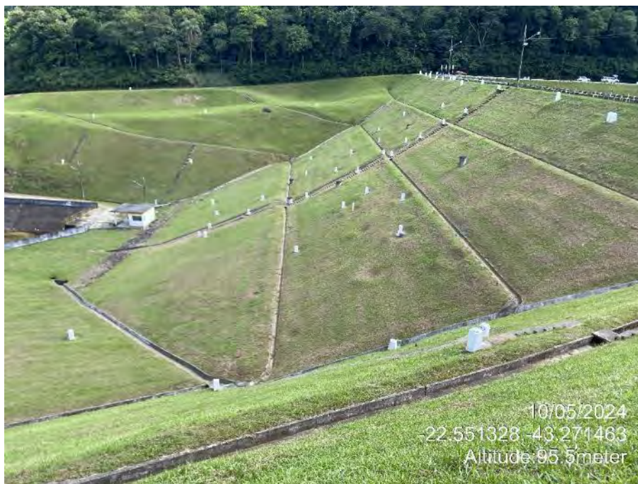
Figura 12: Vista geral do talude de jusante.
