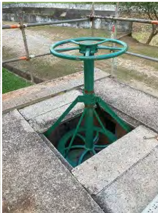
Figura 60: Situação da válvula de gaveta logo após manutenção durante a inspeção de 2023 e atualmente.
