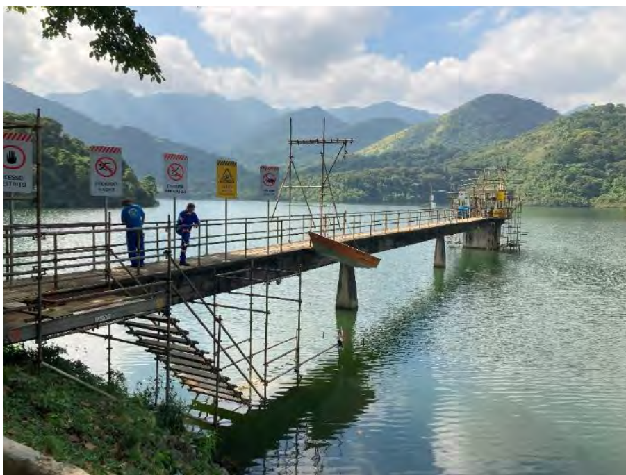
Figura 46: Vista geral da torre de tomada d'água.
