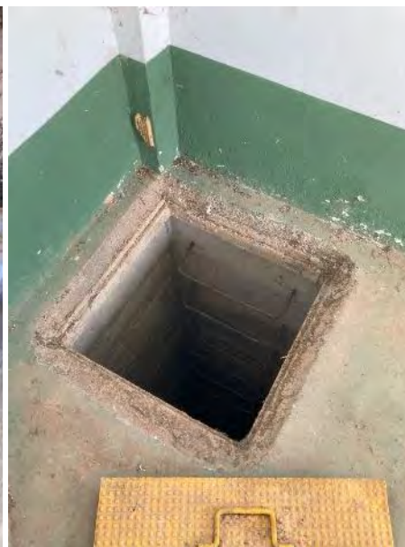
Figura 54: Poço de inspeção do localizado dentro da edificação com escada de acesso sofrendo processo de corrosão e pequeno acúmulo de água no piso.
