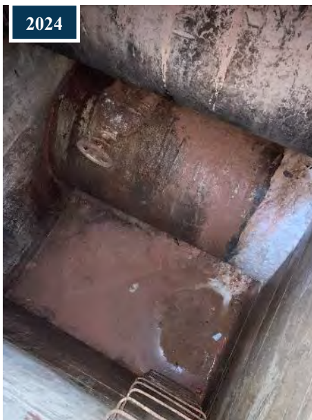
Figura 54: Poço de inspeção do localizado dentro da edificação com escada de acesso sofrendo processo de corrosão e pequeno acúmulo de água no piso.
