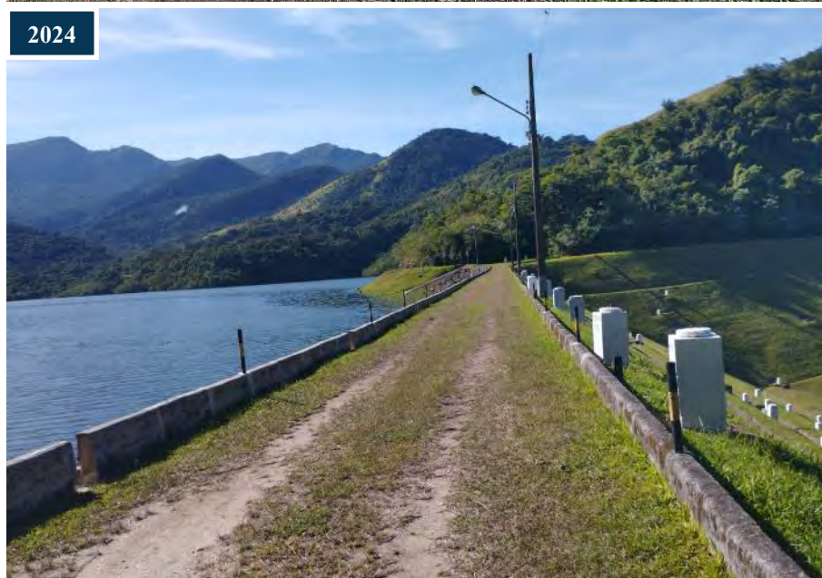
Figura 9: Comparativo entre a falha no revestimento durante a inspeção de 2023 e 2024.
