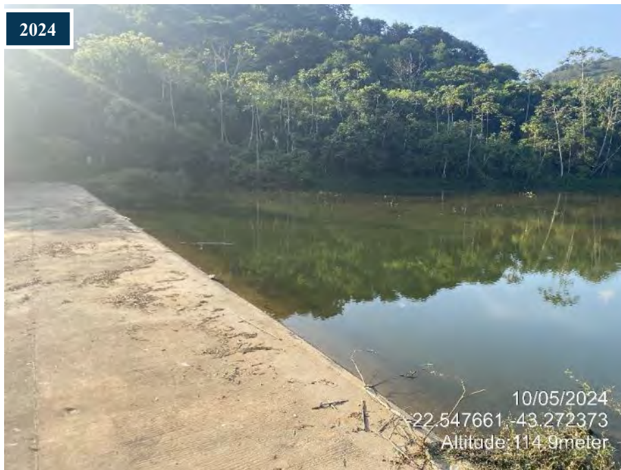
Figura 40: Comparativo entre o entulho e vegetação no canal de aproximação nas inspeções de 2023 e 2024.
