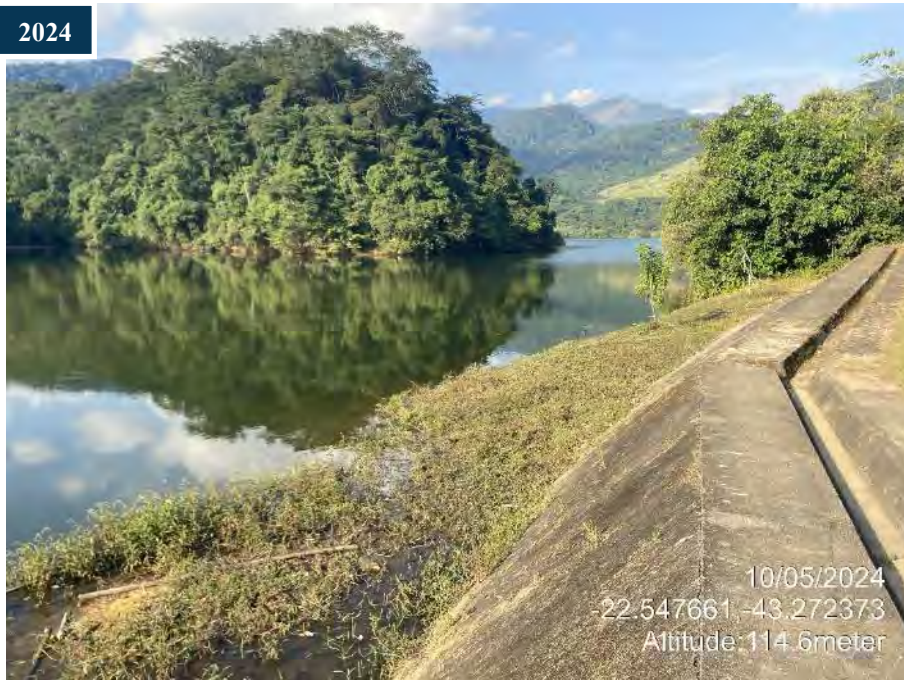
Figura 38: Comparativo do canal de aproximação com obstrução e sedimentos.
