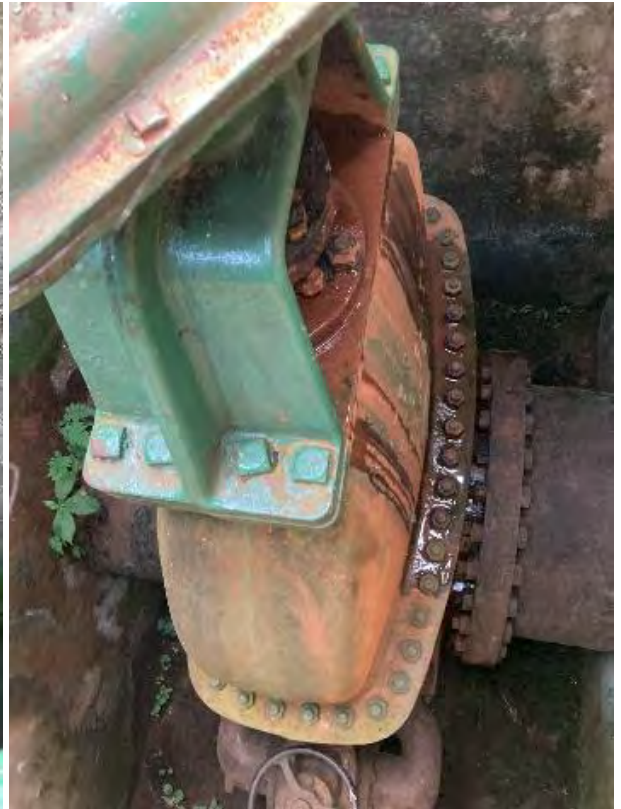
Figura 61: Acesso inadequado e vazamento no castelo do acionamento
