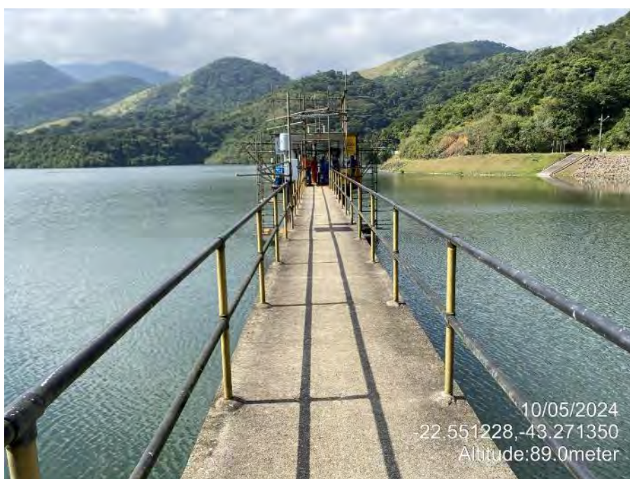
Figura 47: Vista geral da passarela de acesso de torre.
