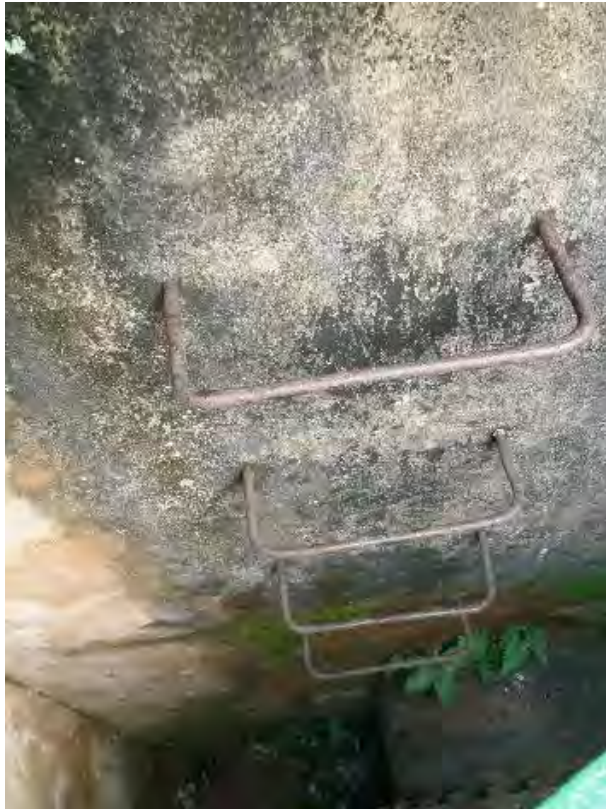
Figura 61: Acesso inadequado e vazamento no castelo do acionamento
