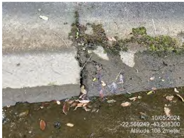
Figura 42: Comparativo das fissuras e deterioração do canal e bacia amortecedora nas inspeções de 2023 e 2024,
